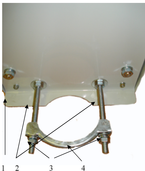
Рисунок 3 – элементы крепление БП к опоре
